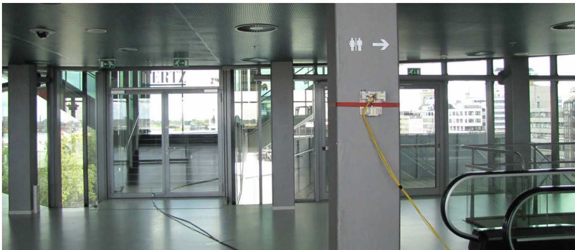
Figuur 11: Meetpunt 1: 3 sensoren op kolom 3
