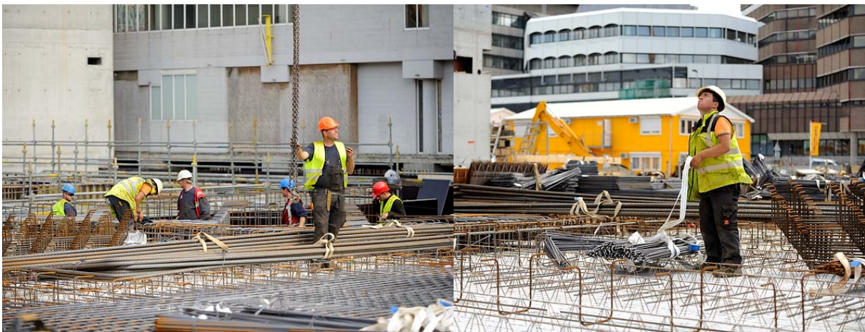
Bouwwerkers aan het werk aan de expeditiekelder van het Muziekpaleis
