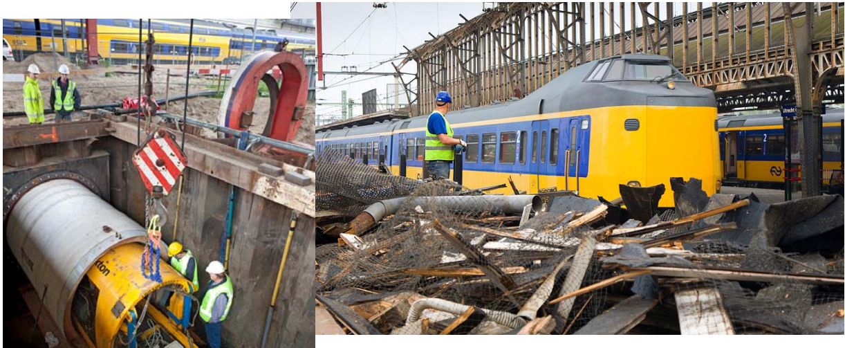
Werken aan het nieuwe Centraal Station
